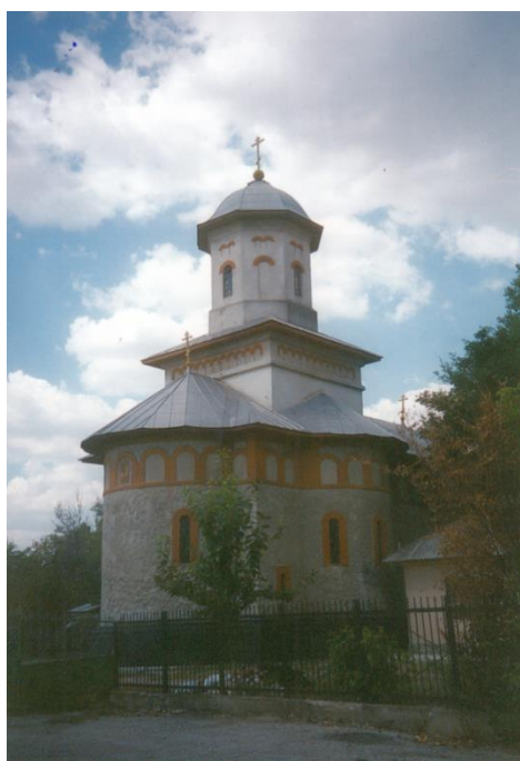
Fot. 2. Cerkiew białokrynicka pw. Michała Archaniola przy ul. Mircea cel Batrin 75 w Bielcach. Fot. Stefan Pastuszewski.
